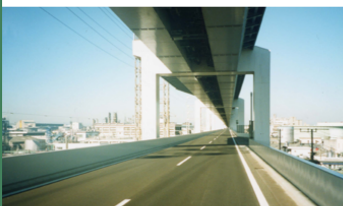
昨年4月、高速川崎縦貫道1期区間(浮島~川崎競馬場)の一部(3.6km)が開通。しかし、車はほとんど走っていない。
