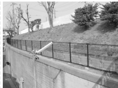
北加瀬側の古市場矢上線のネットフェンスを更新
