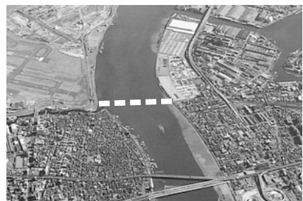
羽田連絡道路の建設予定地、点線は上流案(手前は大師橋)
