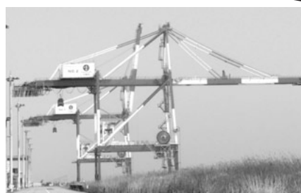
“船の来ない港”に計画 3機目のガントリークレーン
