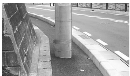
歩道の真ん中に立つ電柱
