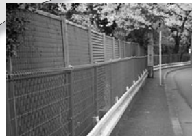
⑤ 設置されたフェンス
