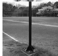
② 改修された外灯
