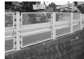
⑥ 取り付けられたガードレール
