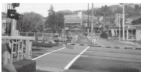
歩道が完成した栗谷踏切
