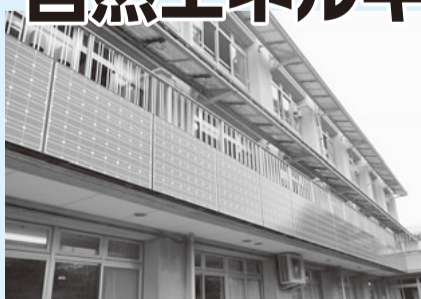
「窓のひさし型」のパネルなど100kwの太陽光発電が設置されている川崎市立西丸子小学校
