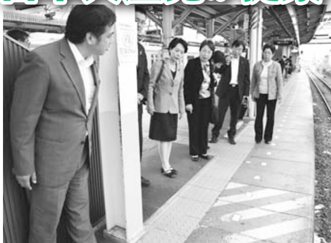
JR川崎駅南武線ホーム、点字ブロックの上に柱が立つ狭くて危険な箇所を調査する共産党市議員と畑野君枝衆院議員(左から3人目)
